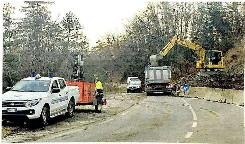
VAL SCURA I tecnici al lavoro, con il supporto della Protezione civile, per ripristinare la viabilità dopo la frana.
